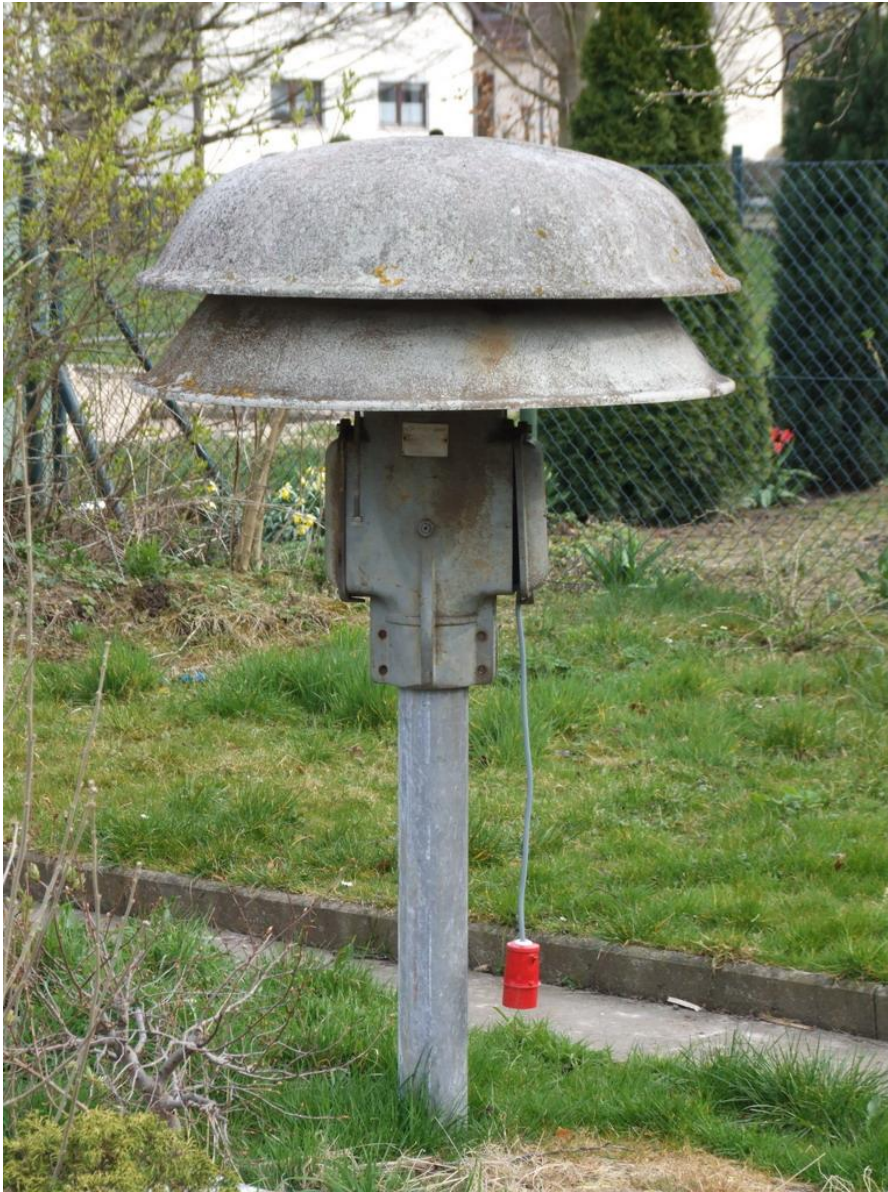
Abbildung 56: Verkackungssirene II, Landert MSL-3 mit 4kW Nennleistung
