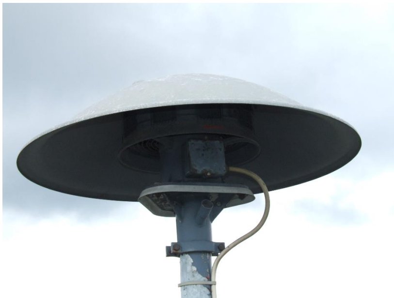
Abbildung 1: Hörmann Motorsirene, Typ E57 (eine super "Verkackungssirene")
