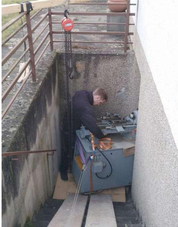
**Abbildung 39: die Maschine geht in die Kurve. Ein weiterer Kettenzug von oben steht schon bereit.**
