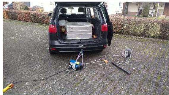
**Abbildung 34:** Gerüstbohlen auf der Treppe sind zwingend erforderlich. Hochgezogen wird die Maschine per Elektrowinde, die an der Anhängerkupplung unseres Autos festgemacht ist.
