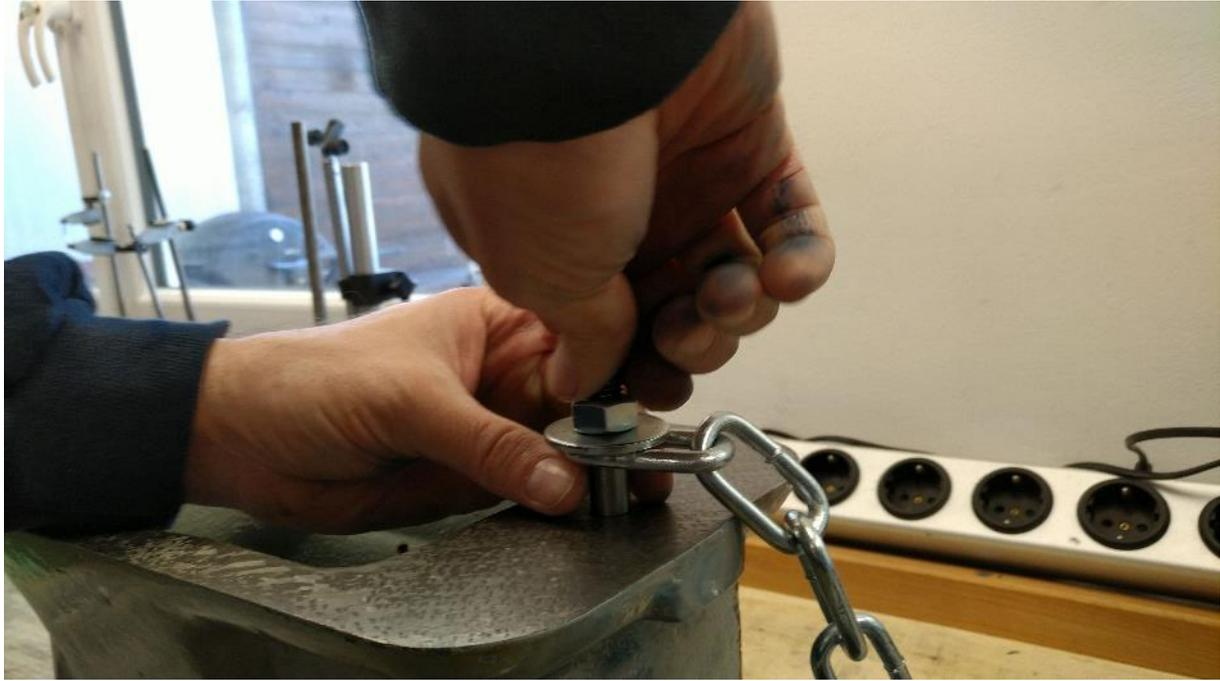
**Abbildung 169: jetzt von unten die Bolzen eindrehen**
