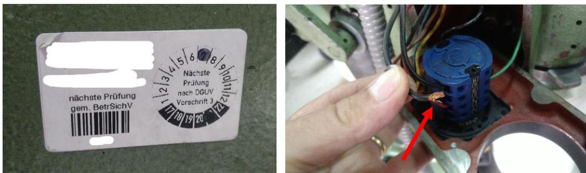
Abbildung 4: Selbst erlebt: außen hui, innen pfui! - Litze ohne Aderendhülse in einem Schalter. Und das trotz erfolgter und bestandener elektrischer Prüfung!
